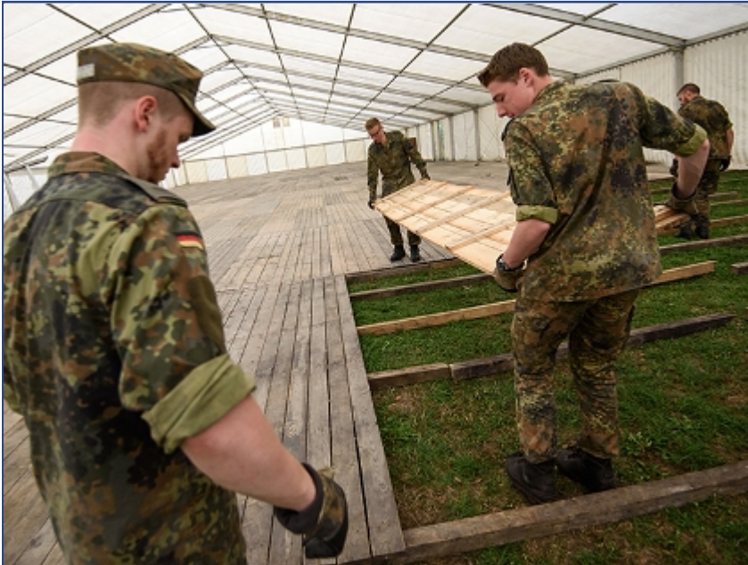
Soldaten verlegen einen Holzboden in einem Großraumzelt (Quelle: dpa/Armer) Größere Abbildung anzeigen
